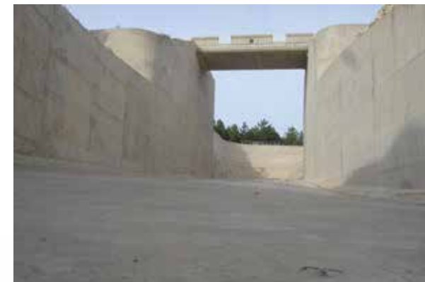
Αγωγός υπερχείλισης, Φράγμα Ασπρόκρεμμου Πάφου © TomasNY, wikimedia commons
